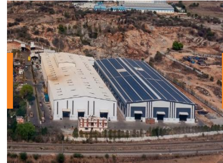
Mahabubnagar Unit-IV Telangana
